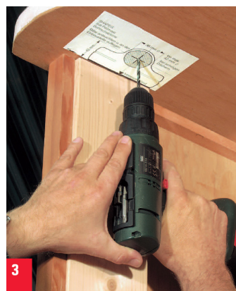
3. Bohrschablone an die Decke anbringen und Zentrierloch bohren. Die Bohrschablone finden Sie im Abschnitt Bohrschablone , S. 7.
