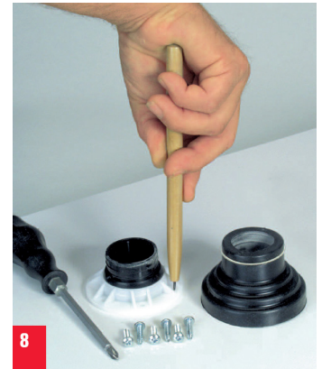
8. Löcher in der Dachdurchführung mit Vorstecher einstechen. Bei Kunststoffdächern Löcher mit Bohrer \varnothing 3,5 mm vorbohren.
