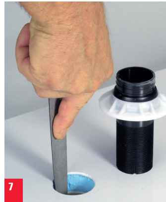
7. Loch ausfeilen. Dachdurchführung einsetzen.
