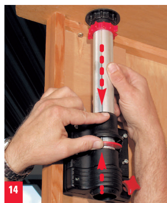
14. Automatik-Klemmplatte nach oben drücken und Antennenrohr einführen. Antennenmast senkrecht anbringen, sodass er sich leicht schieben lässt.
